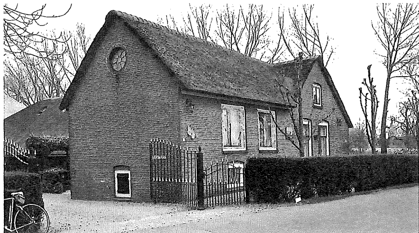
Landvermaak, gezien vanuit het noorden met kaaskelder, venster en luik
